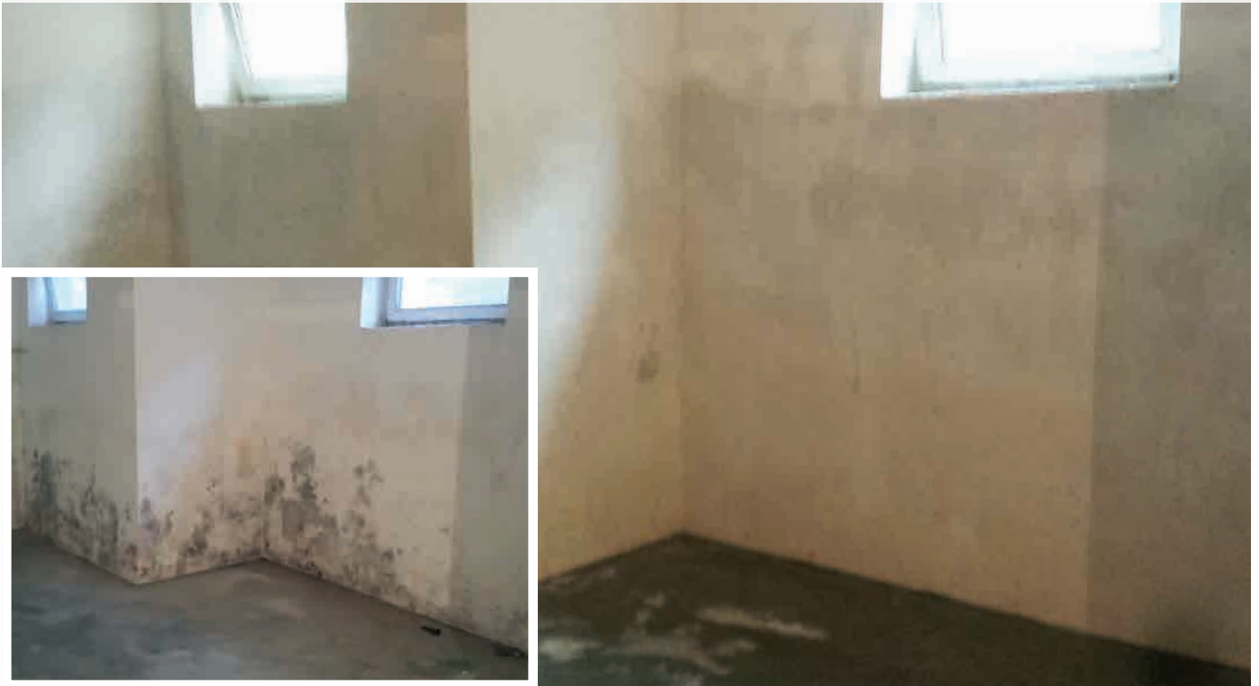
Entschimmelung verputzter Oberflächen
